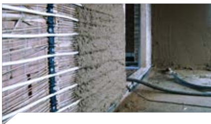
Wand- und Deckenheizung
